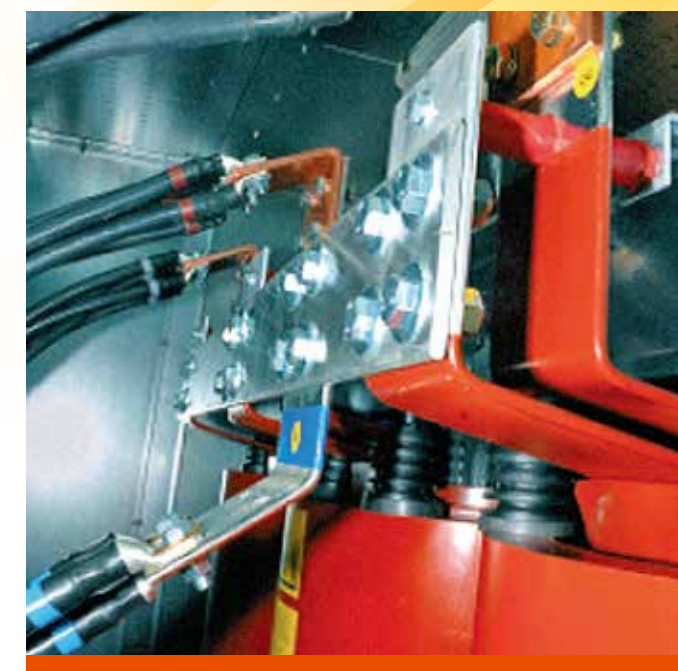
Монтаж ВВ вводов на трансформатор
