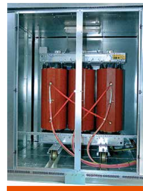
Отсек силового трансформатора
